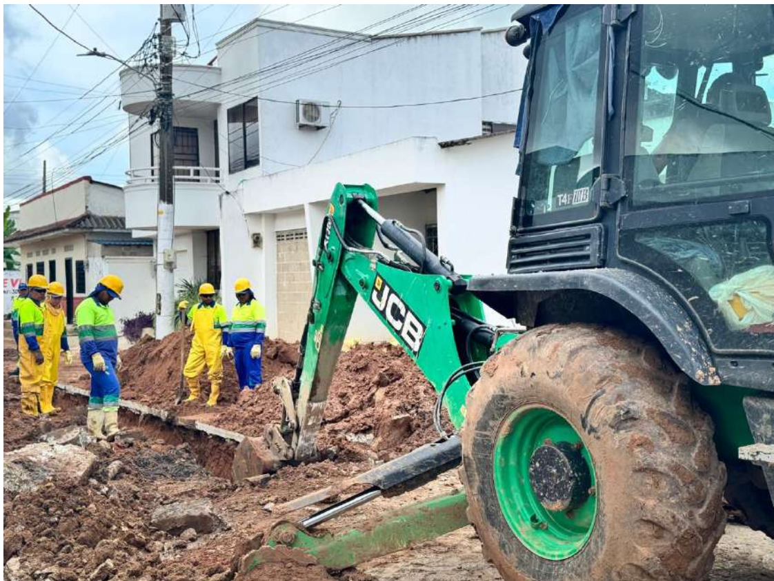
Imagen - Trabajos de Aqualia en Sahagún
