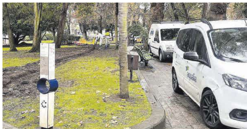
Operarios de Aqualia, ayer, trabajando en una de las zanjas.
