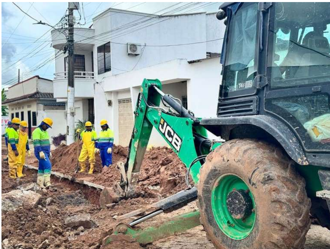
Aqualia renueva el alcantarillado de Sahagún para fortalecer la salubridad y la infraestructura.
