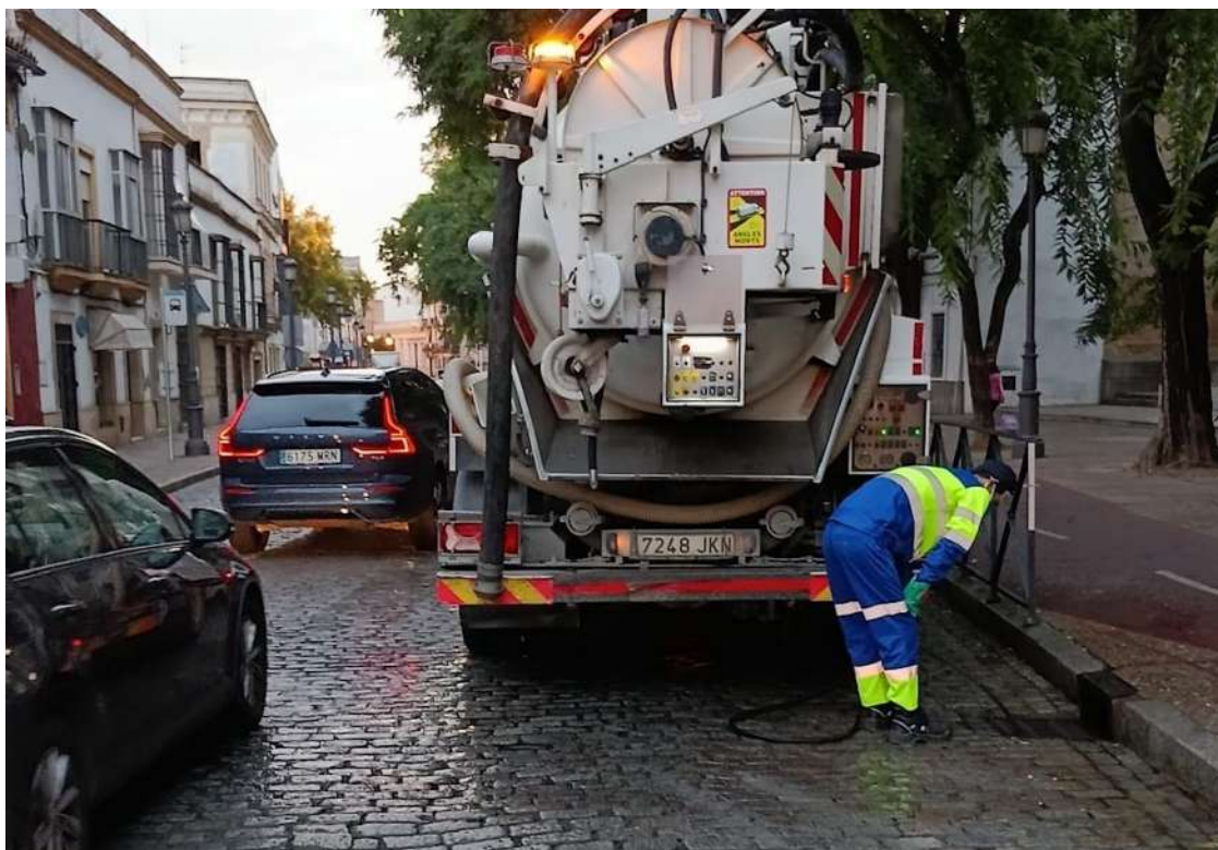
Un operario de Aquajerez en las tareas de limpieza de alcantarillas e imbornales
