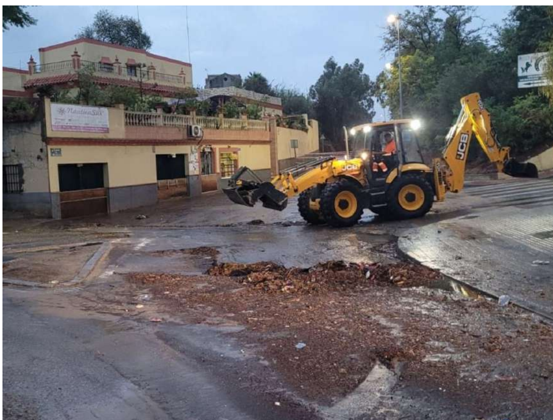
Operarios trabajando en una zona afectada por las lluvias en Sanlúcar.
