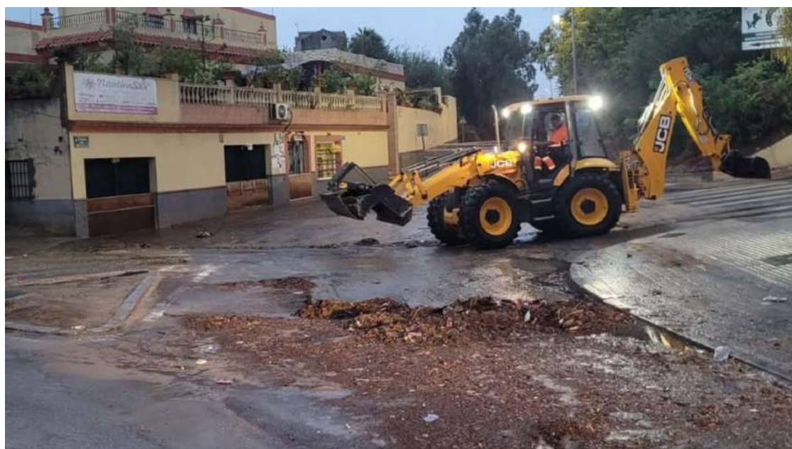
Los operarios municipales de Sanlúcar trabajando para devolver la normalidad al municipio
