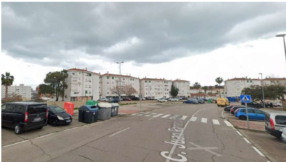
Corte temporal de agua en la calle Juan Ramón Jiménez de Algeciras por avería
