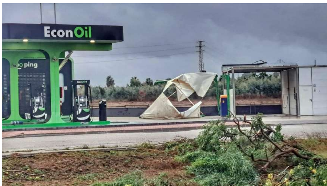
Destrozos en Rota por el paso de una manga marina
